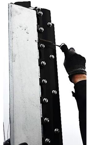
Figure 2 – Bouclier – 2 crochets tiennent le bouclier.
